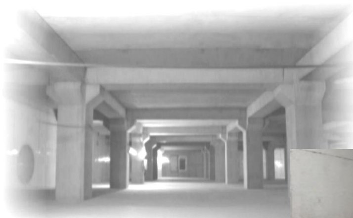
大州雨水貯留池の内部
