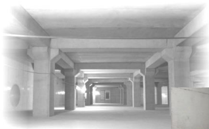
大州雨水貯留池の内部
