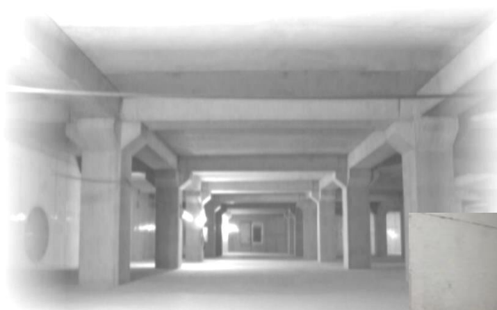
大州雨水貯留池の内部
