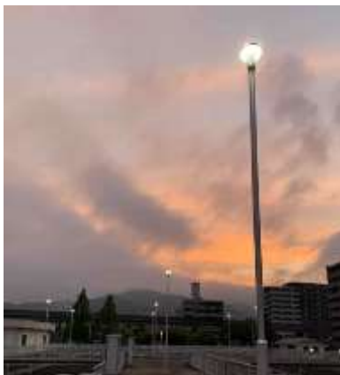
牛田浄水場 LED 照明
