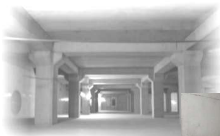
大州雨水貯留池の内部
