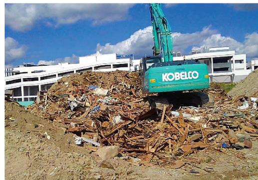
写真 2-1-2 がれき混じり土砂等の処理の様子
