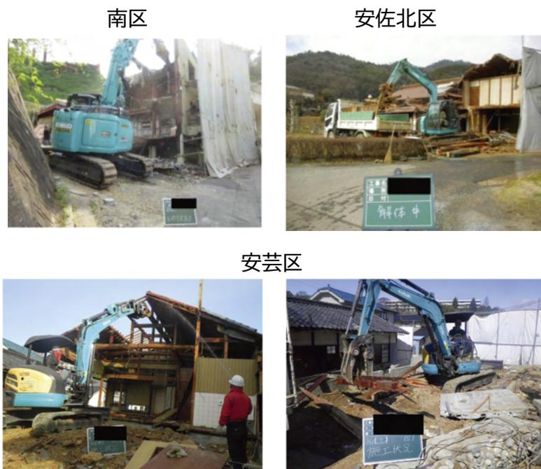
写真 2-9-4 被災家屋の解体・撤去の状況
