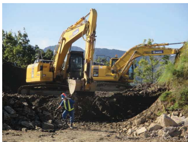
5 消防訓練用地 【H27.10.7 作業風景】
