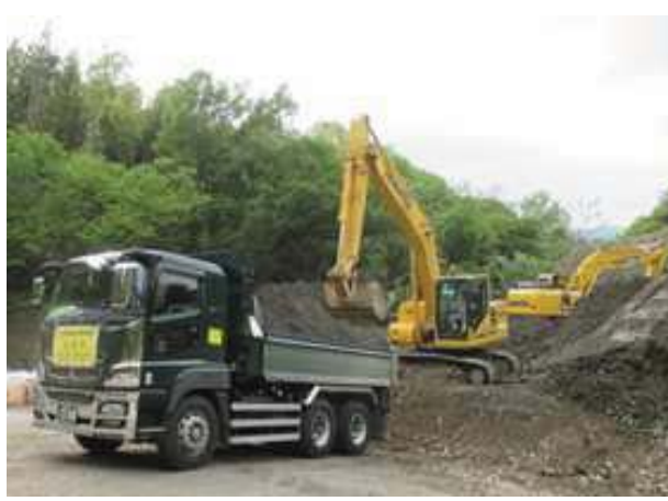
6 水道局用地(高陽浄水場近接) 【H27.4.30 作業風景】
