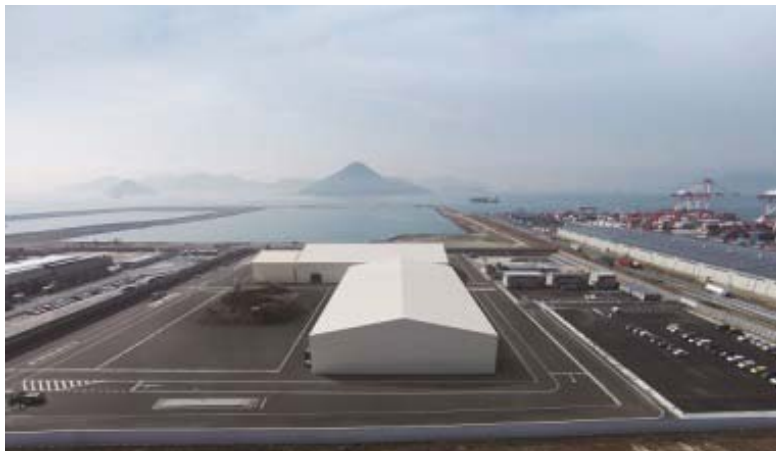
写真 3-5-1 災害廃棄物中間処理施設
