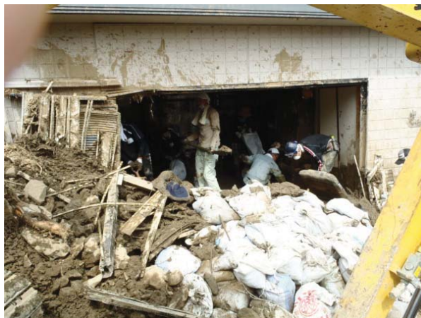
写真 1-5-2 ボランティアによる土砂等撤去
