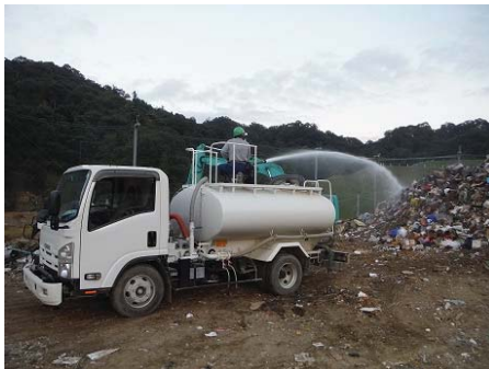
写真 1-2-4 散水車両を活用し洗浄
