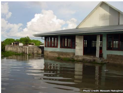
▲海面の上昇による町の浸水
