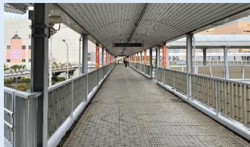
ペDESTロリアンデッキ
