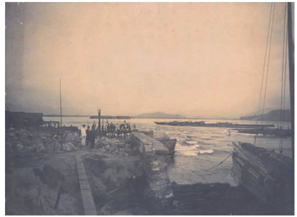
写真4 堤防を破壊し、宇品干拓地に流入する海水。破壊された堤防から干拓地方面（北方）を望む。台湾陸軍補給廠宇品支廠があるのは写真の右側（明治33年8月、片山精三撮影）
