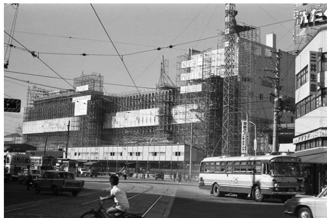
広島駅 建設中の駅ビル 昭和 40 (1965) 年夏頃
