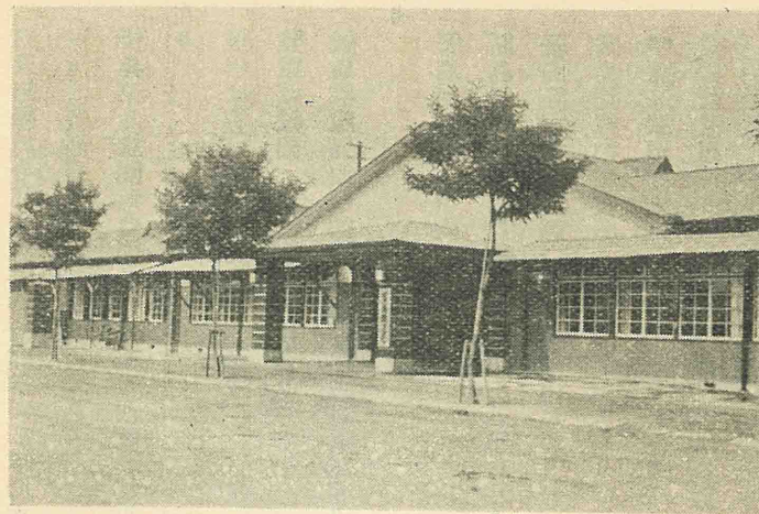
廣島鐵道局假廳舎
