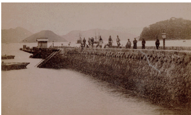
写真6 築港当時の宇品港栈橋 石を斜めにして積む谷積みで築かれている。
