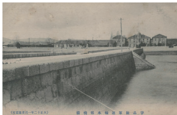
写真7 大正時代の軍用栈橋 石を横向きにして各段の高さを揃える布積みで築かれている。
