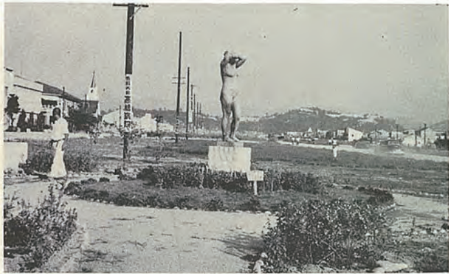
市内中央部を東西に貫く平和大通（百米道路）
