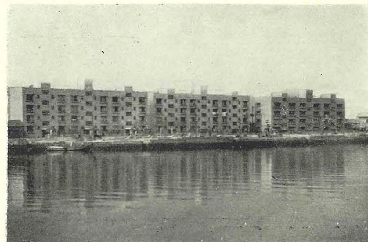
市営鉄筋コンクリートアパート（昭和町）
