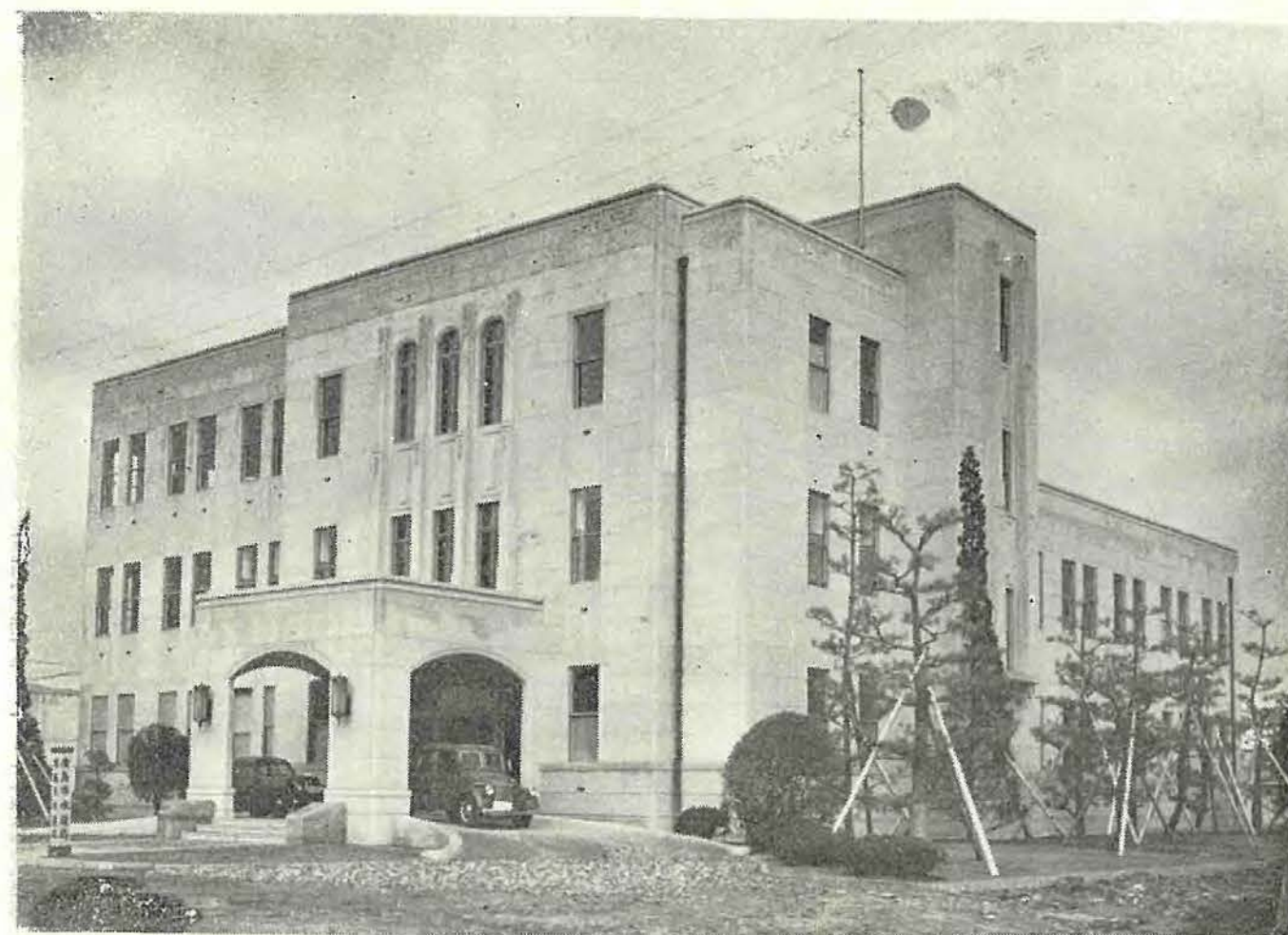
新築なつた市水道局庁舎
