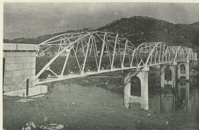
神田橋水管橋(900口径)
