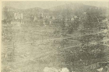
中國配電會社屋上より東北廣島驛方面の被爆状況
