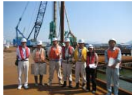
橋梁の建設現場を視察
