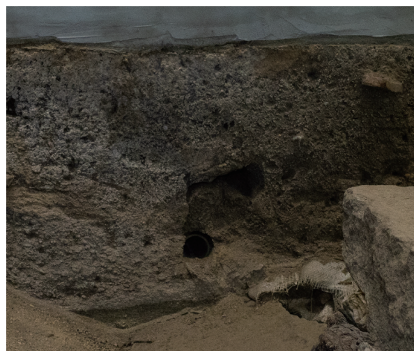
11/15 白い物質析出部分 拡大写真②
