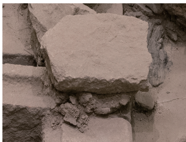
2024/7/16 下層部の土層部分が崩壊した。
