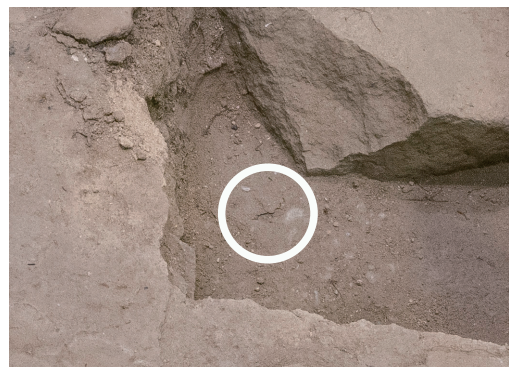
2022/8/24 拡大写真 亀裂がはじめて確認された
