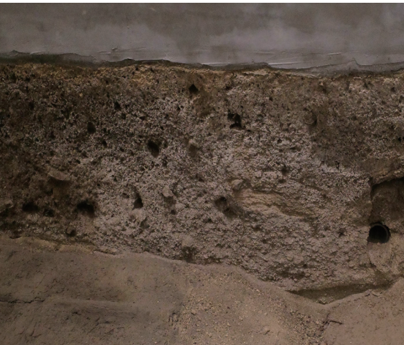
9/17 白い物質析出部分 拡大写真①
