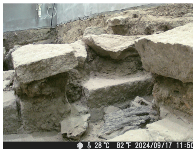
2024/9/17 定点カメラ画像 崩壊後から変化は見られない。
