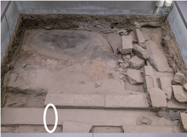
白丸部分に亀裂を確認した
