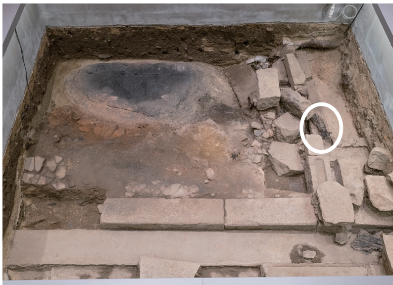
2022/5/16 丸印の部分が崩壊。
