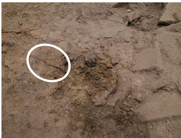
2024/2/15 析出物は除去後から大きな変化はみられない が、析出物周辺に5cm程度の亀裂を確認した。
