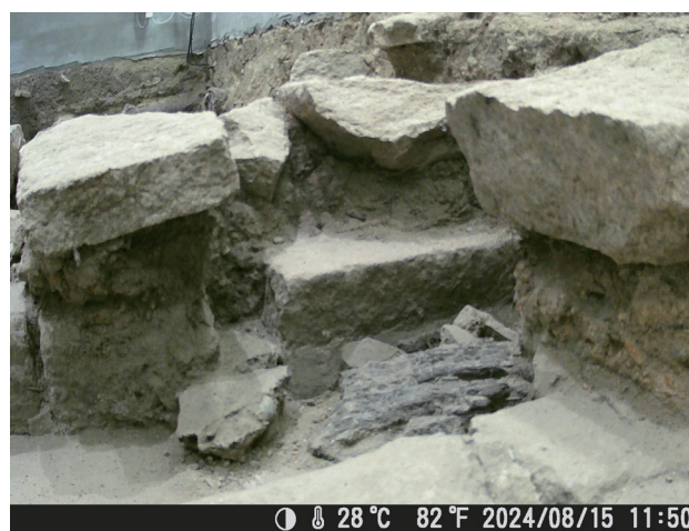
2024/8/15 定点カメラ画像 崩壊後から変化は見られない。
