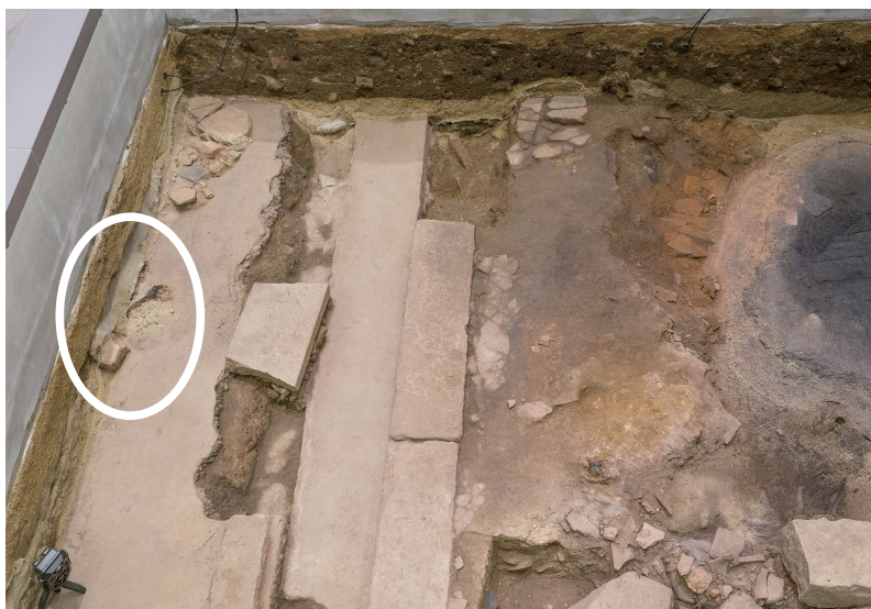
2022/5/16 丸印の部分が崩壊。
