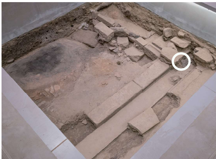
2023/6/15 丸印の部分の崩壊を確認した。
