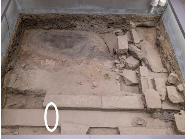
白丸部分に亀裂を確認した
