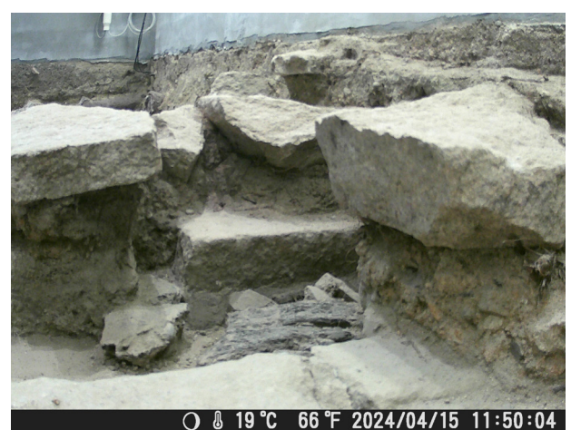
4/15 定点カメラ画像 崩壊後から変化は見られない。
