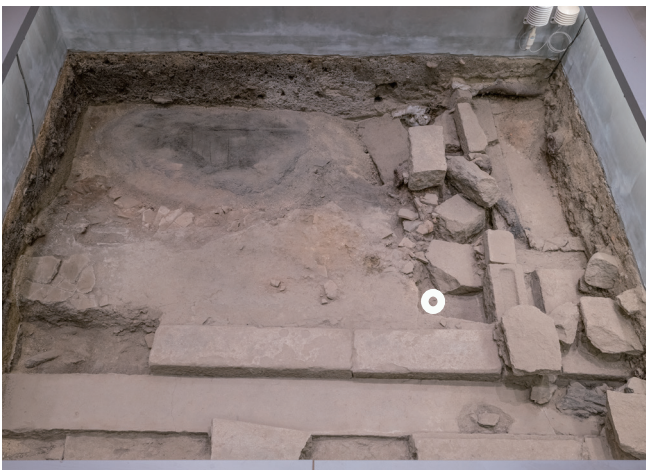
白丸部分に亀裂を確認した
