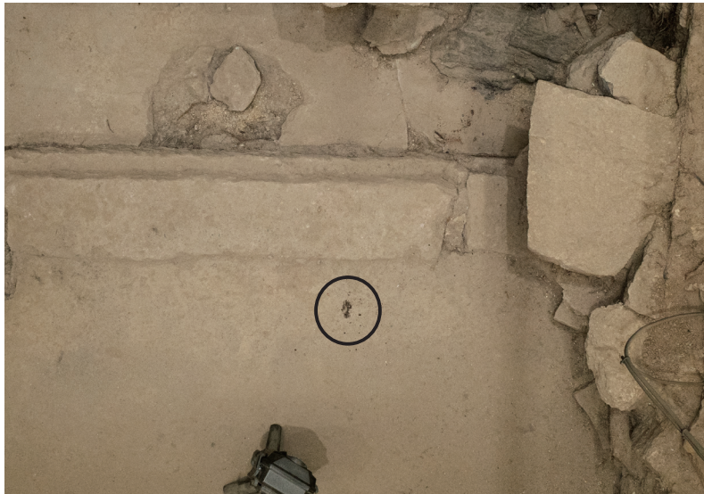
2025/1/15 アスファルト面の陥没を確認
