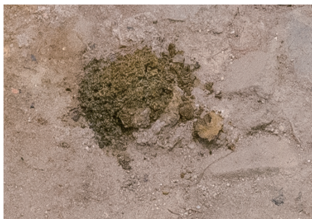
2023/10/13 析出した状況
