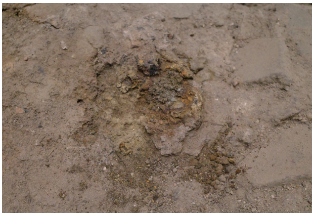
2023/9/14 析出物除去後の様子。
