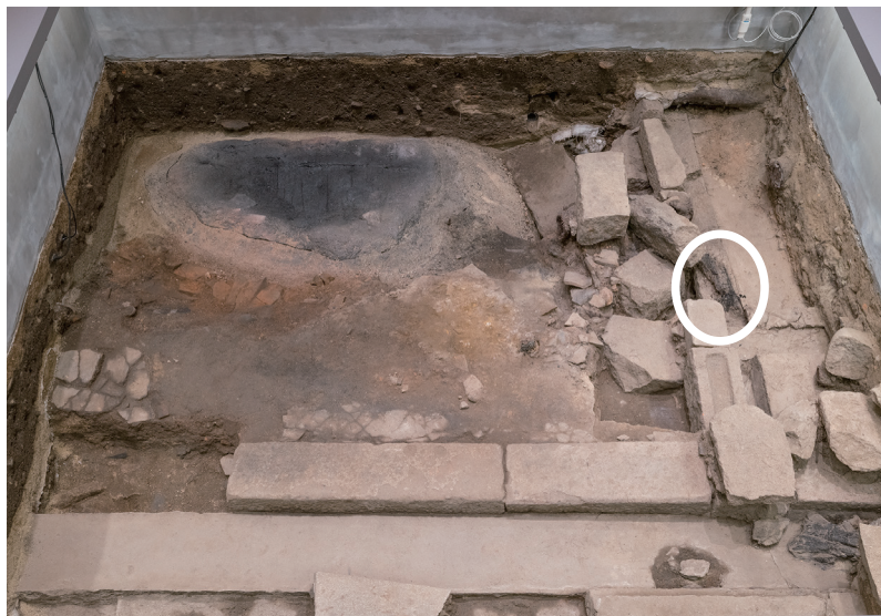
R4/5/16 丸印の部分が崩壊。
