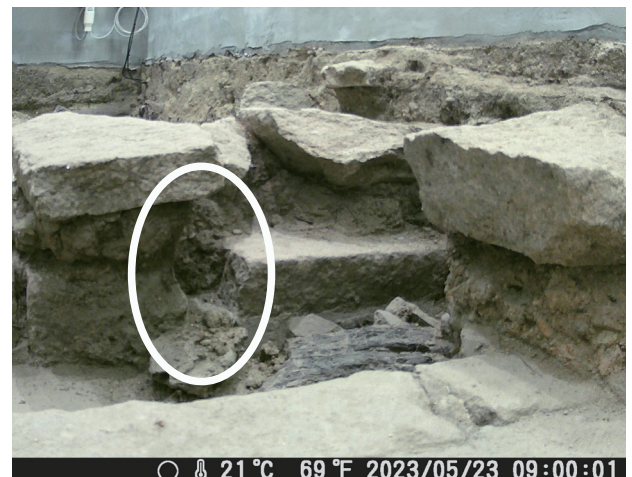
5/23 定点カメラ画像 石列下層部の土層部分が崩壊している。
