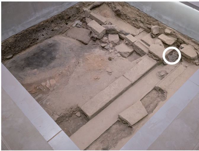
R5/6/15 丸印の部分の崩壊を確認した。
