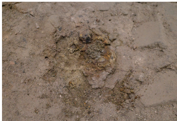
9/14 析出物除去後の様子。
