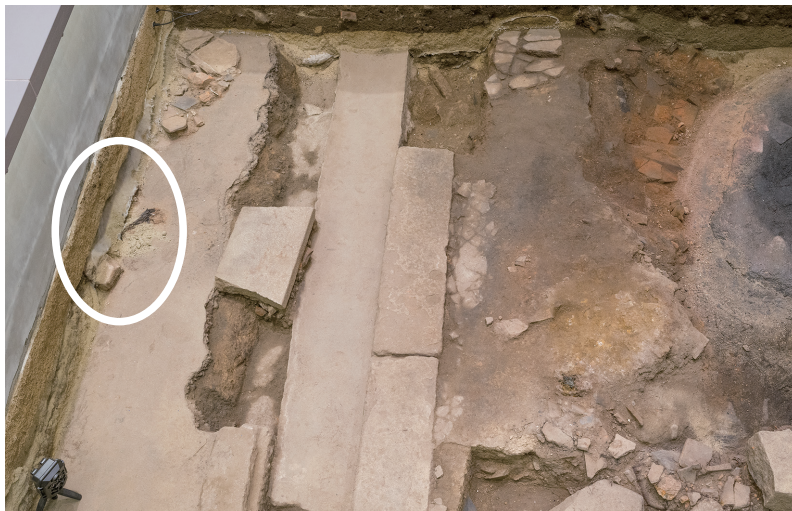
R4/5/16 丸印の部分が崩壊。
