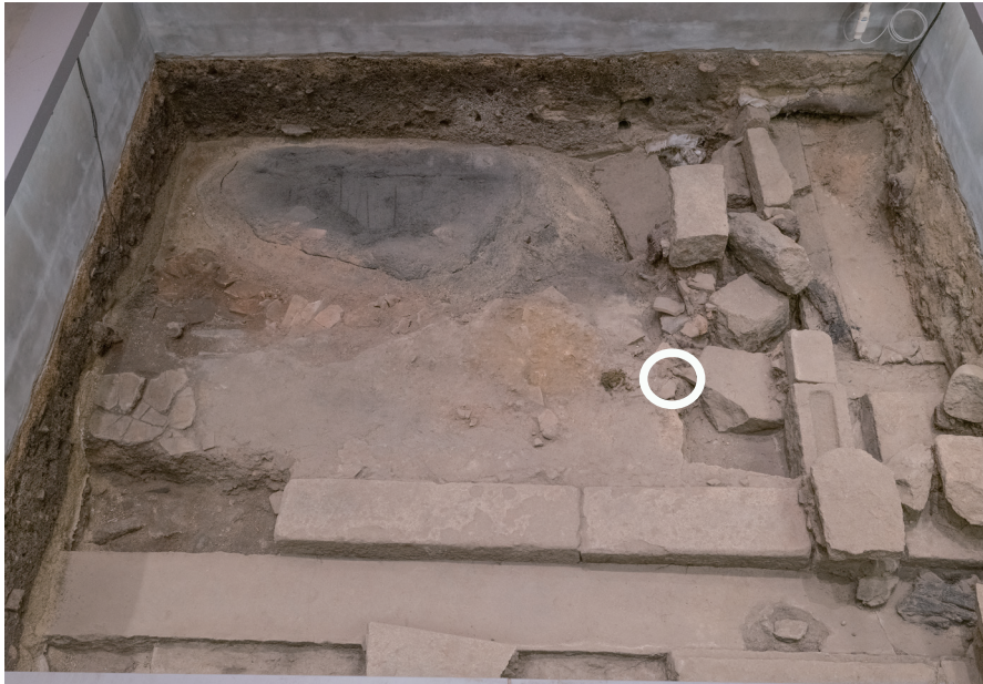
12/14 丸印の部分で崩壊が見られた。
