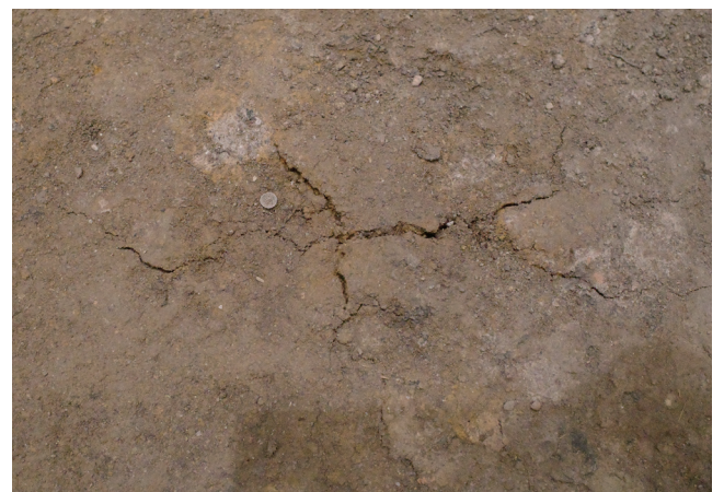
2/15 亀裂の範囲 東西方向：9.5 c m程度 南北方向：4.8 c m程度
