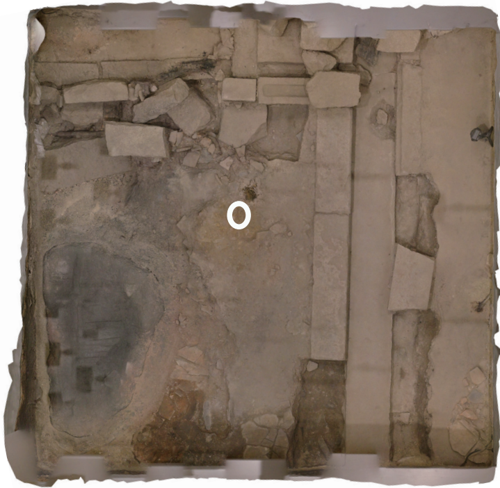
12/14 丸印の部分に亀裂が入っている。
