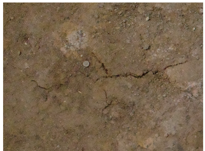
1/11 亀裂の範囲 東西方向：9.1 c m程度 南北方向：4.8 c m程度
