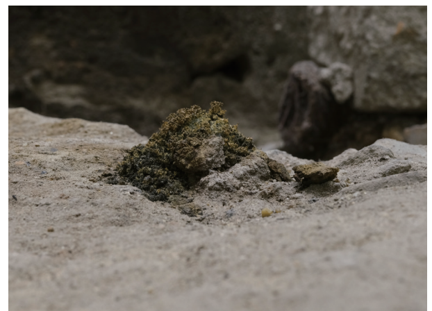
10/13 横から見ると、下層部が表出していること がよくわかる。
