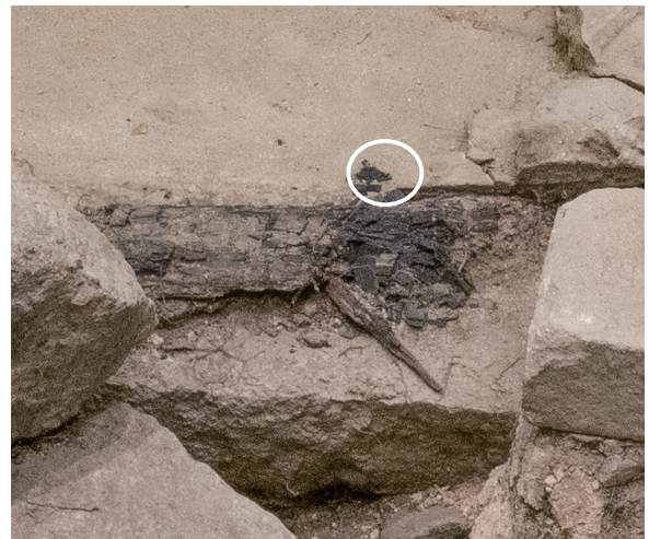
7/14 丸印の部分が5月よりも崩れている。
