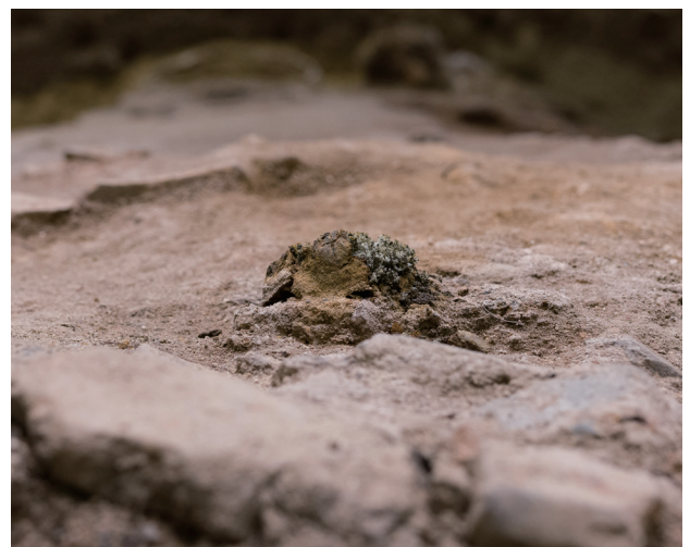
6/16 塩が析出したと思われる場所は、横 から見ると隆起している。
