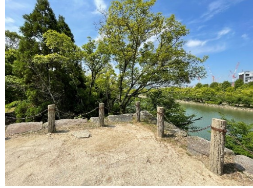
天守台の進入防止柵
