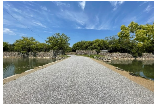
裏御門跡前土橋
