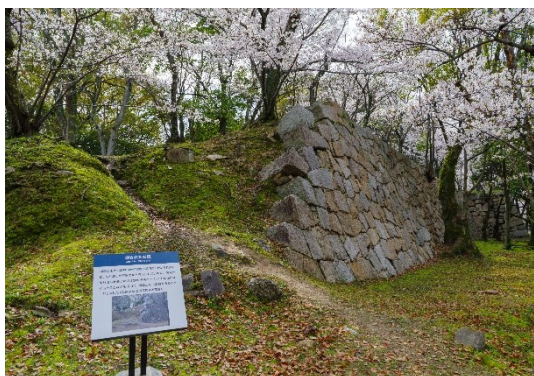
[8] 東側石垣東端に見られる破却痕跡
