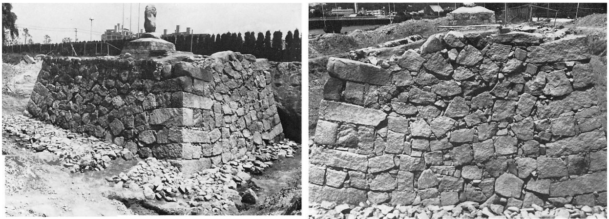
外郭櫓台検出状況
