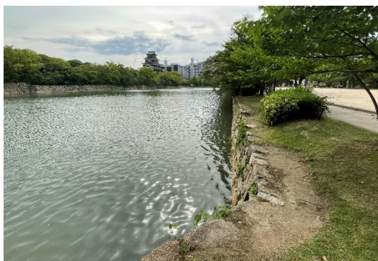
堀の石垣の天端石
