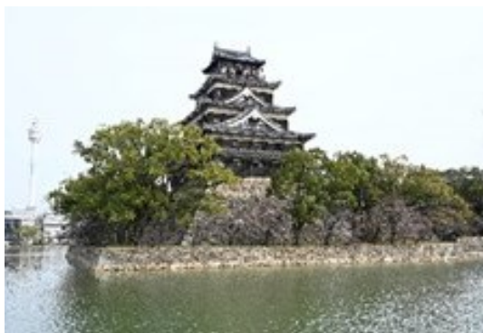
[9] 石垣（西内堀北側）
