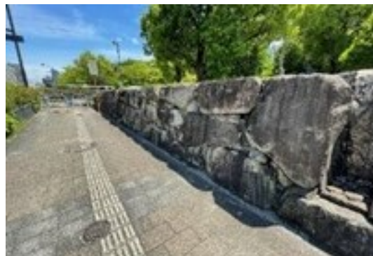
[8] 中堀石垣(三ノ丸)
