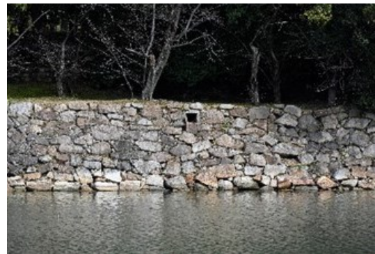
[8] 石垣（西内堀北側）
