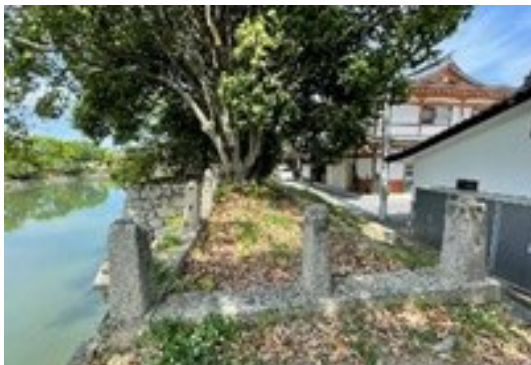
[21] 陸軍時代の櫓台改変箇所
