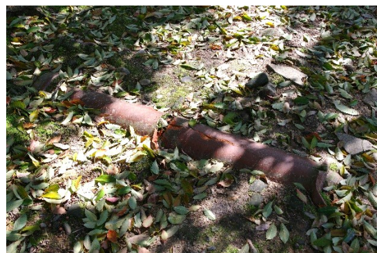
雨水排水管の露出
