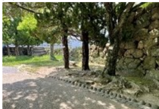
[30] 園路と土留め縁石
