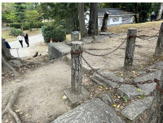
[6] 南側石垣上面に見られる櫓台の重複状況
