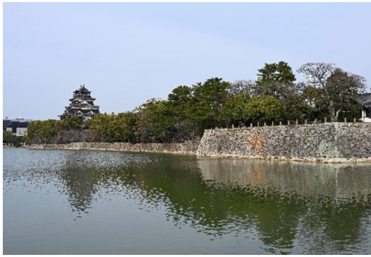
[1] 西内堀（南西から）
