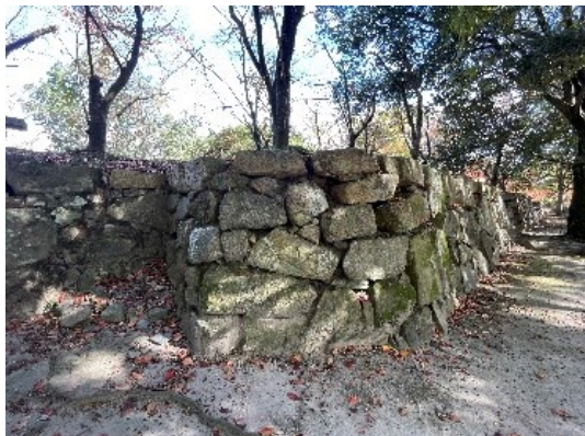
[10] 東側石垣南面の鎬（しのぎ）部
