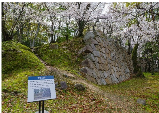
[8] 東側石垣東端に見られる破却痕跡
