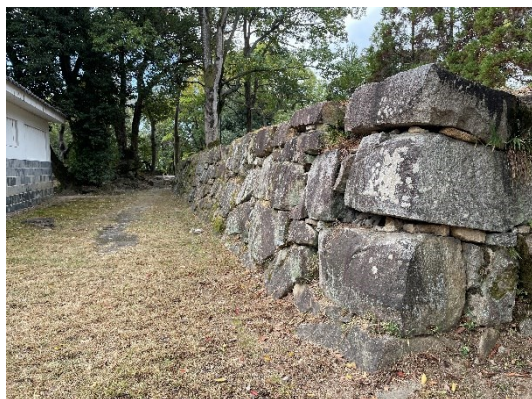
[3] 南側石垣東面
