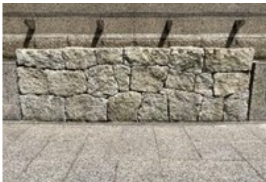
[7] 県庁西側地下街出入口の石垣
