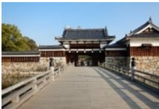
[9] 復元建造物（御門橋）
