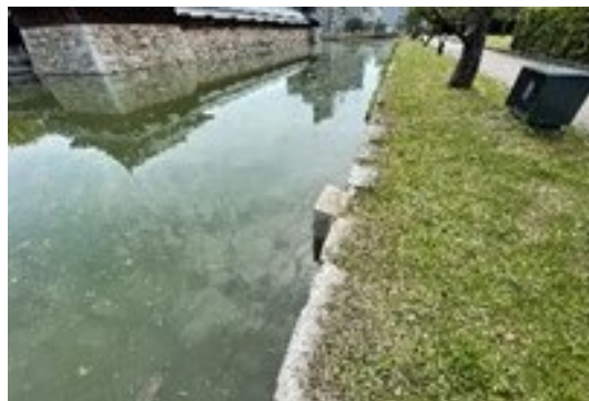
[4] 内堀南側暗渠の位置
