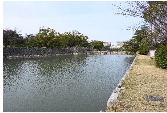
[2] 東内堀（南東から）
