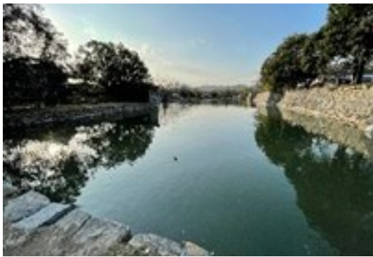
[1] 二の丸北側内堀（土橋西）
