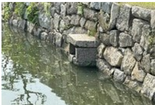
[5] 内堀南側暗渠
