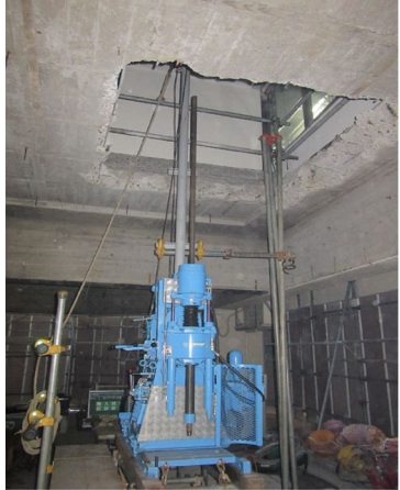
屋内作業状況
