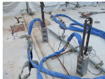
写真 18 コア穴破碎器
