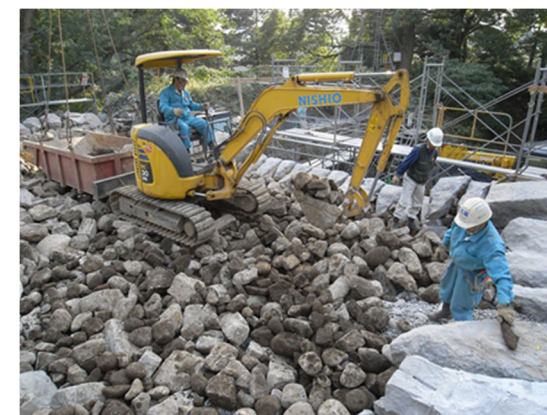
写真 22 0.18 m 3 バックホウ使用状況
