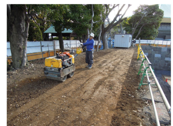
写真 23 振動ローラ使用状況
