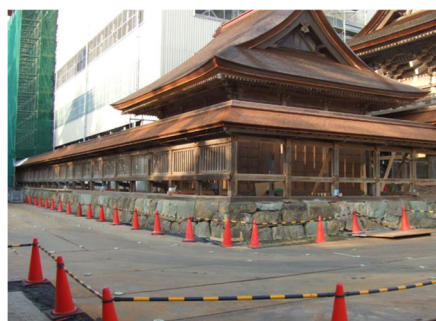
写真9 史跡内での道敷鉄板養生の例
