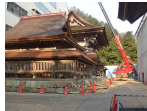
写真4 敷鉄板養生のイメージ
