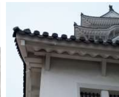
姫路城備前門 出桁と方杖
