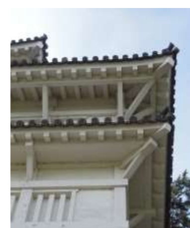
岡山城西手櫓 出桁と方杖
