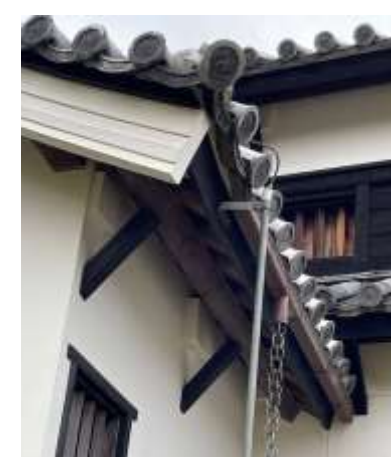
福岡城多門櫓 出桁と方杖
