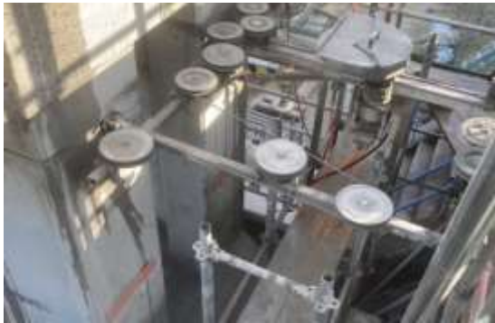
写真2 ブロック解体のイメージ（ワイヤーソー）
