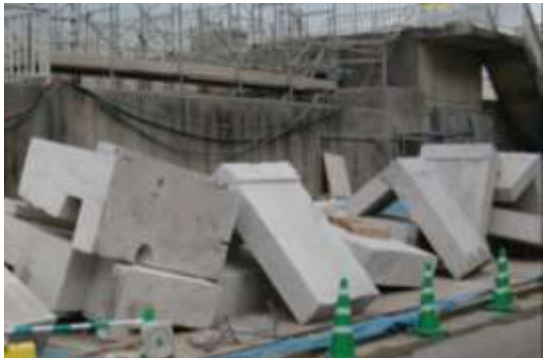
写真3 ブロック解体の解体後のイメージ
