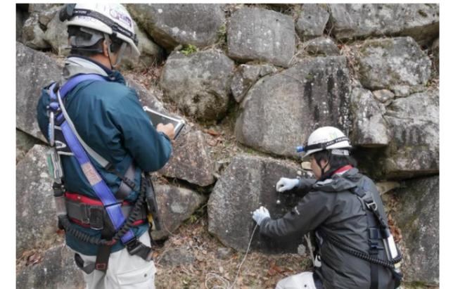
C) 3次元補完測量 (3次元レーザ測量)
