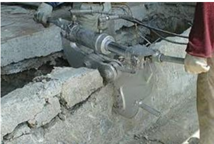
ハンドクラッシャーによる作業員解体例
