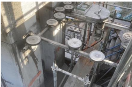
ワイヤーソーによるブロック解体例
