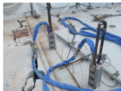
写真 18 コア穴破碎器
