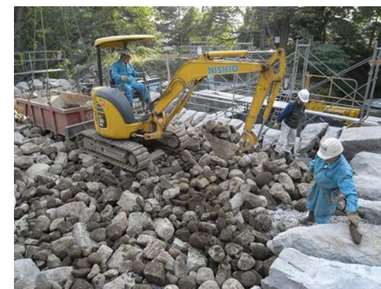
写真 22 0.18 m 3 バックホウ使用状況
