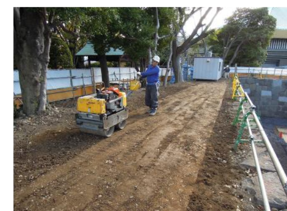
写真 23 振動ローラ使用状況
