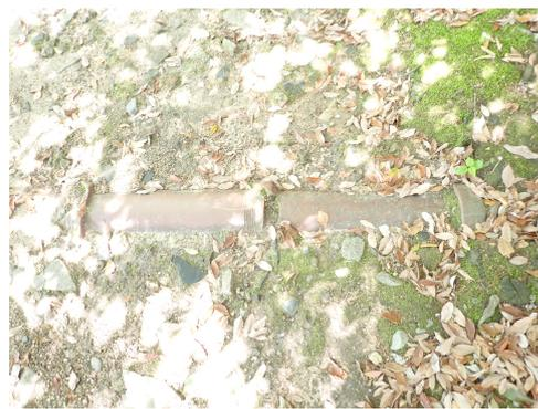
写真 10-2 雨水排水管の露出
